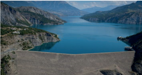
Credit photo : Serre-Ponçon operator EDF
