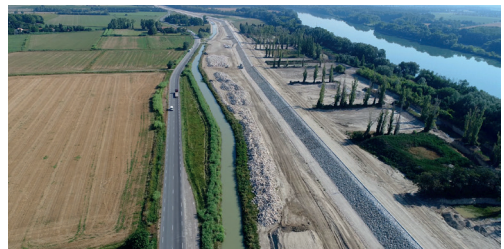
Credit photo : Digue de Camargue. operator SYMADREM
